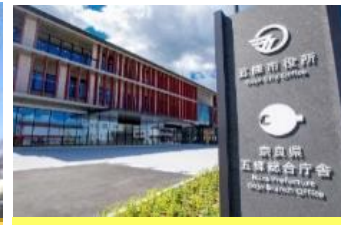
五條土木事務所
