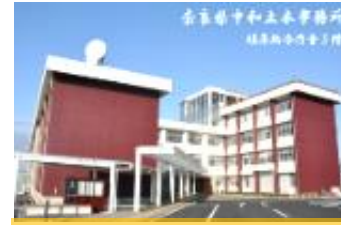
中和土木事務所
