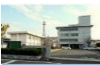
高田土木事務所
